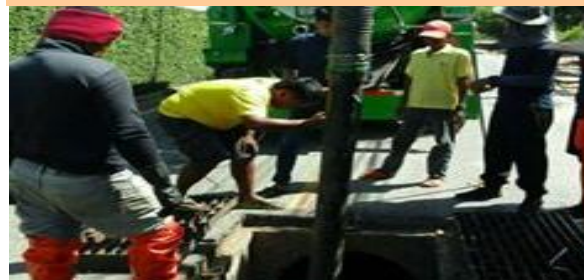
รณรงค์ดูแลสิ่งแวดล้อมท่อระบายน้ำ เดือน มีนาคม 2559
